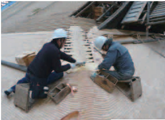
建仁寺の保存修理工事
