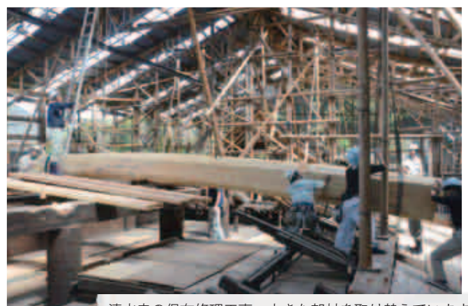
清水寺の保存修理工事。大きな部材を取り替えています
